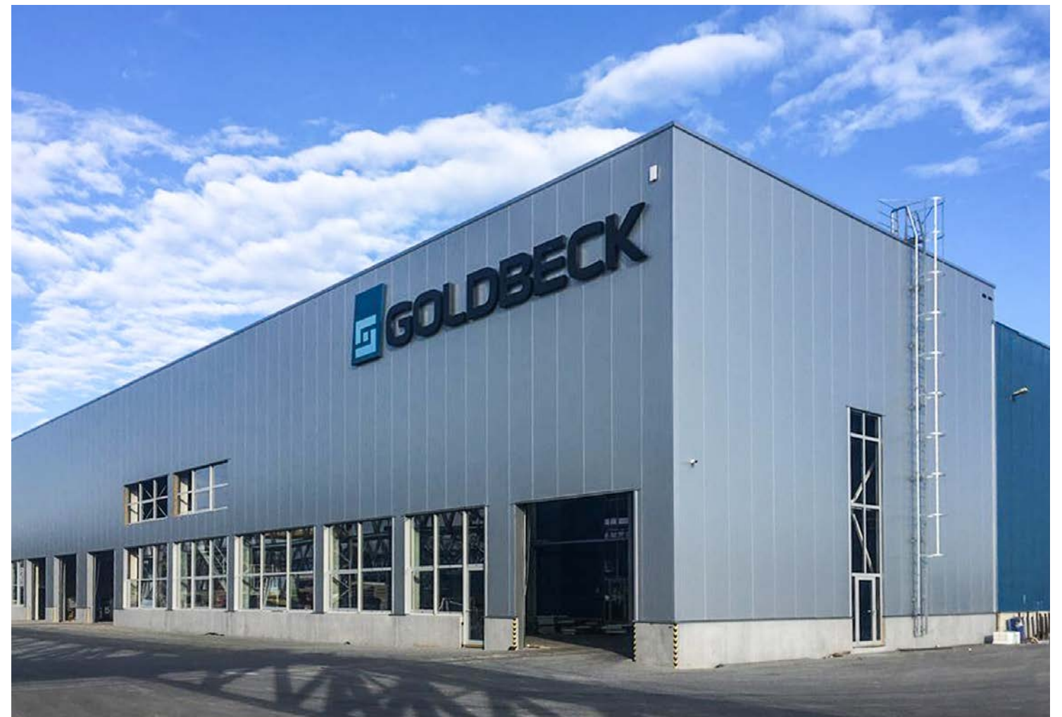
GOLDBECK Prefabeton SPI, Vrdu 1.165 m 2 Úžitková plocha
